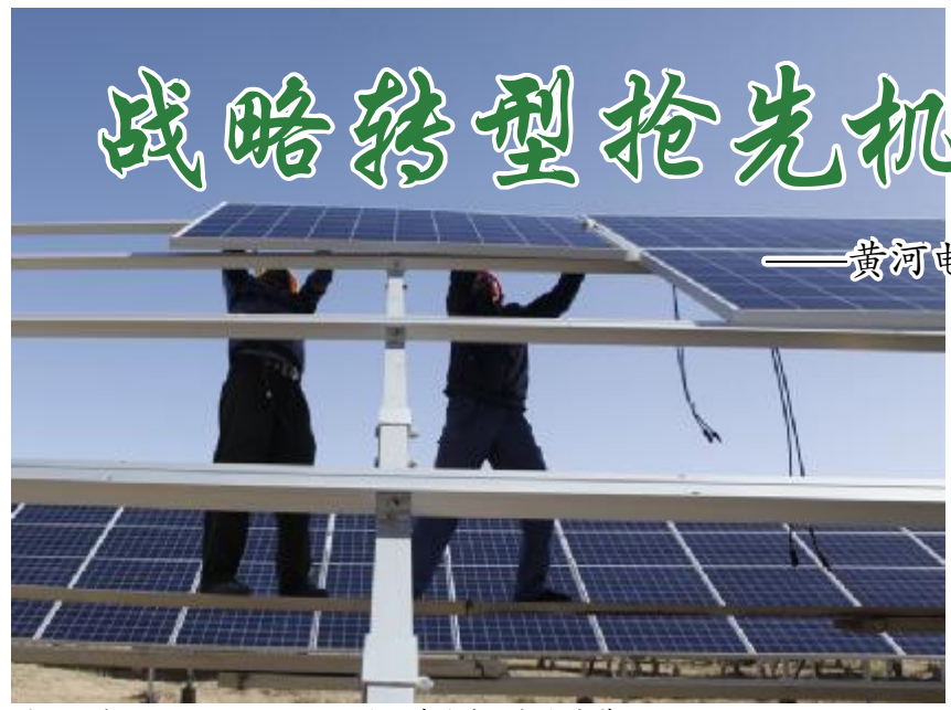
共和三期200兆瓦及100兆瓦试验基地光伏电站安装
