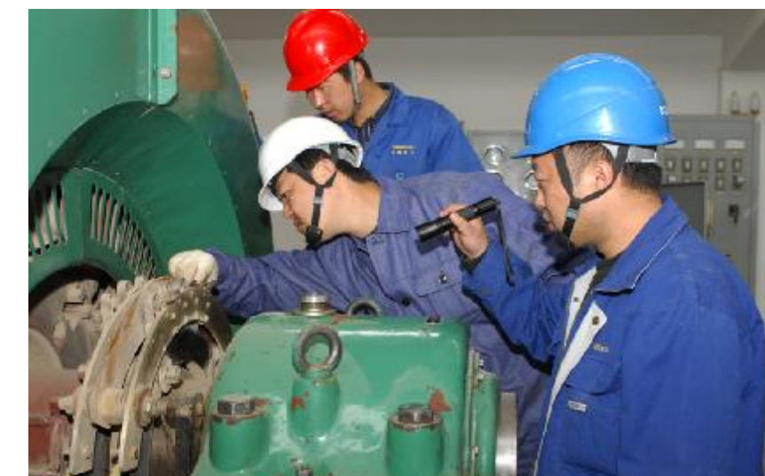
玉树地震灾区电站抢修现场
